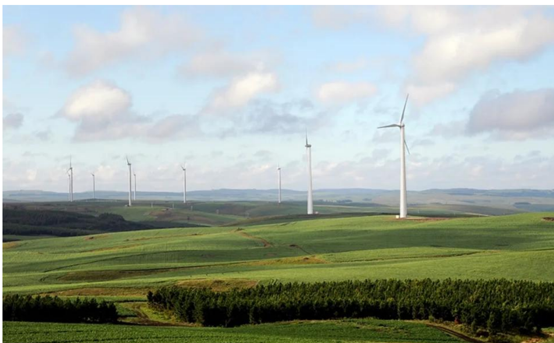
Complexo Eólico Água Doce, o maior de Santa Catarina, capaz de gerar até 129 MW de energia
