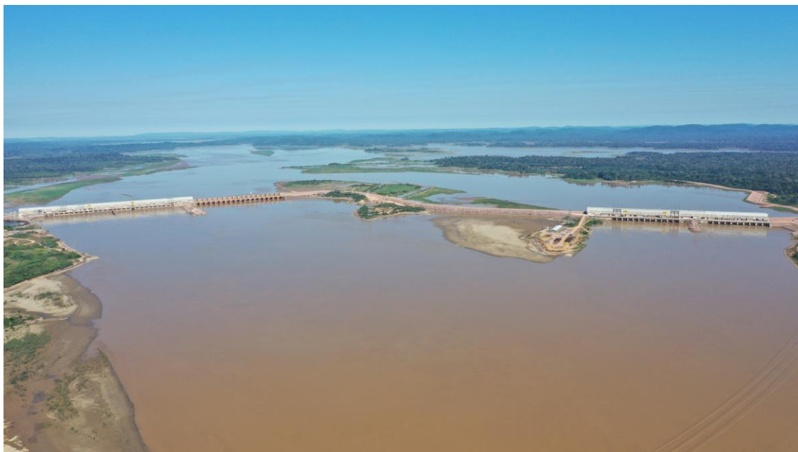
Usina Hidrelétrica Jirau
