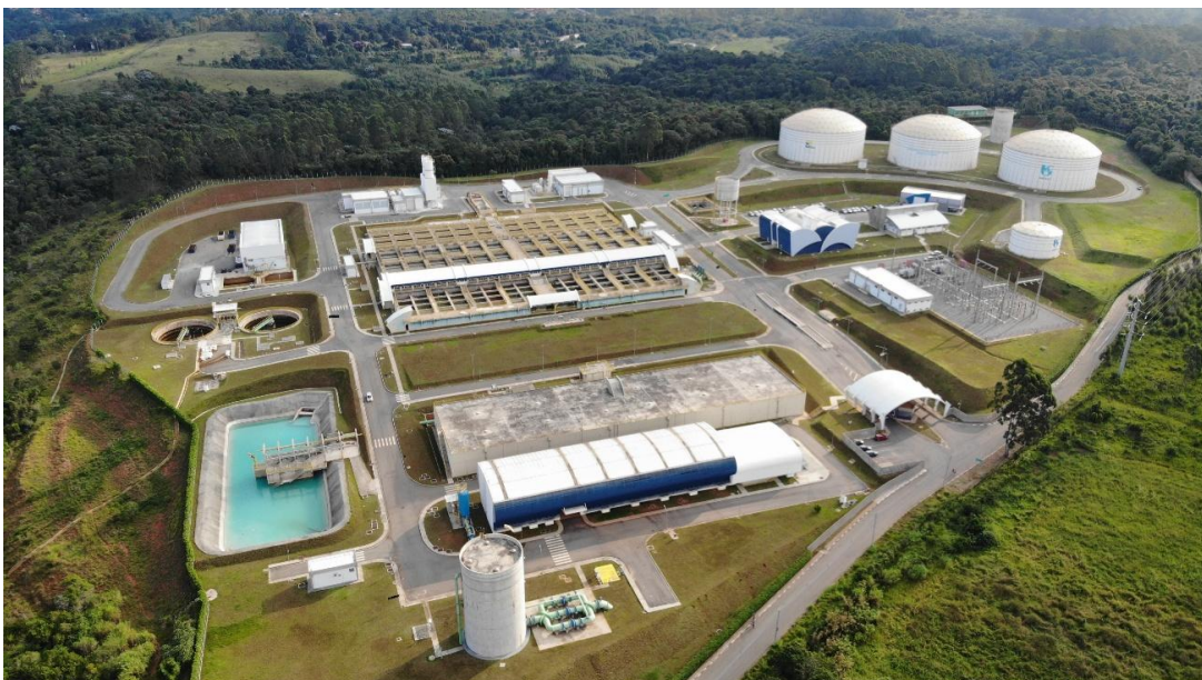
Sistema Produtor São Lourenço
