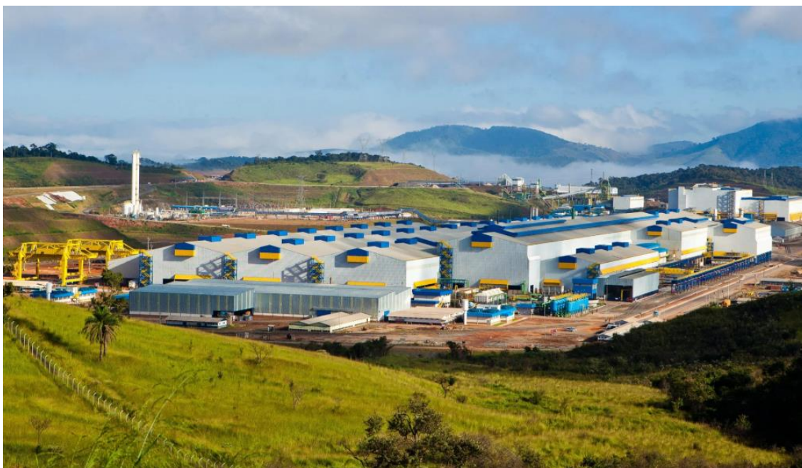
Usina da Vallourec em Jeceaba
