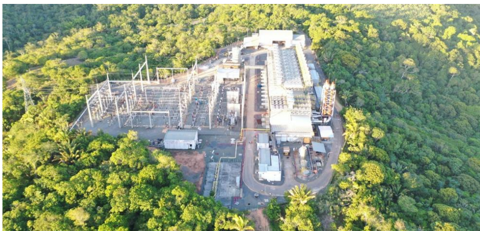
Usinas da Imetame Termelétrica
