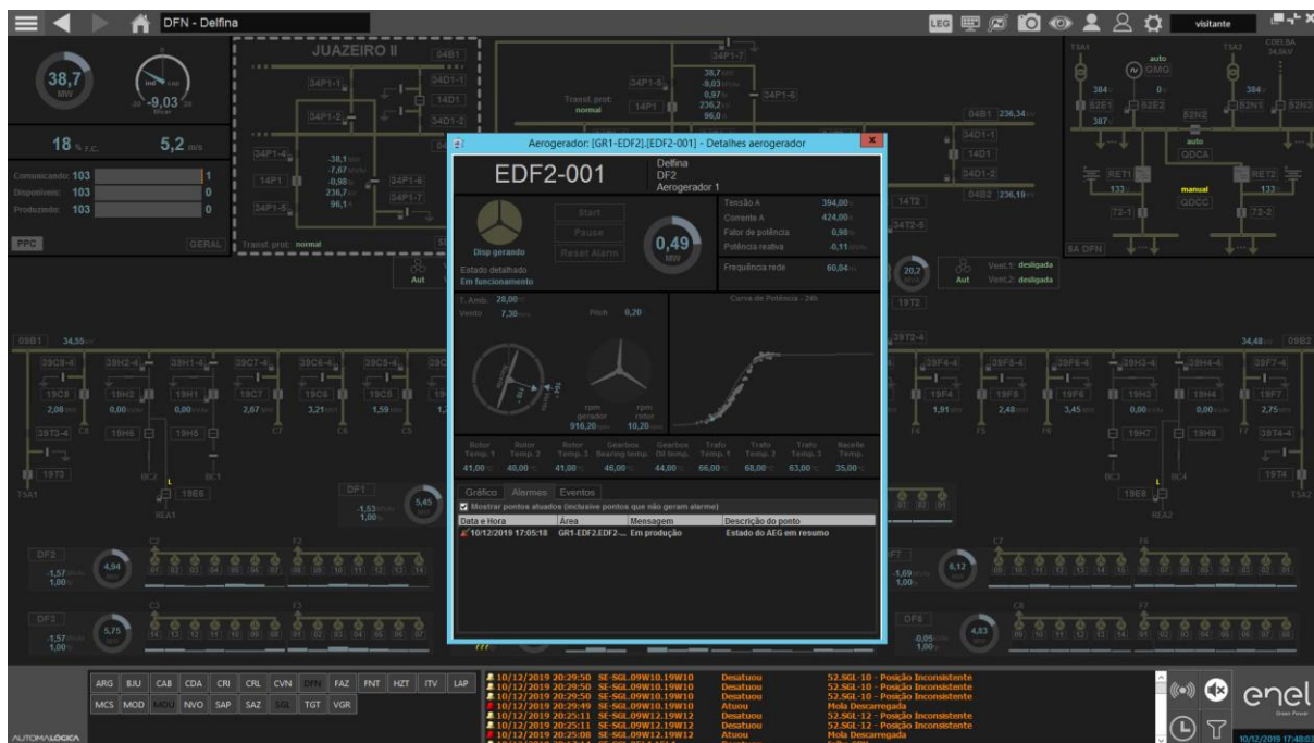
Controle de um dos aerogeradores do parque eólico de Delfina
