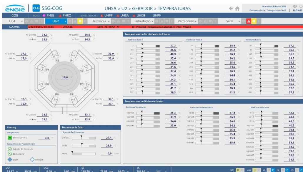
Figura 4. Controle das temperaturas dos enrolamentos e ranhuras das turbinas
