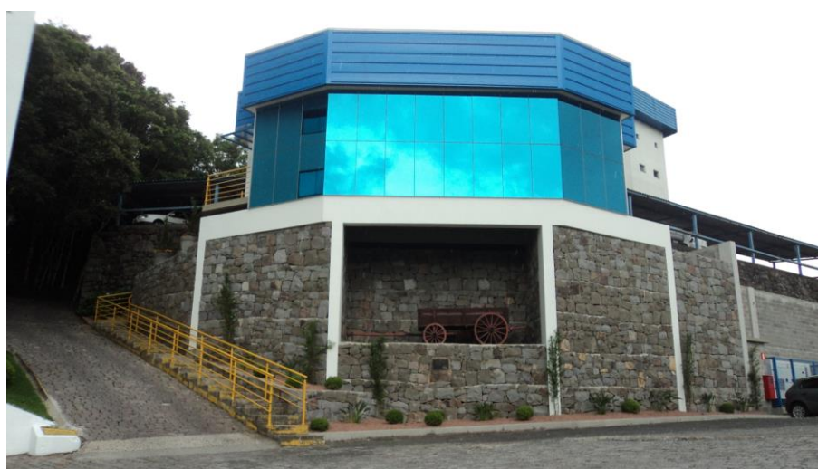
Figura 2. Vista frontal do Data Center da TBL
