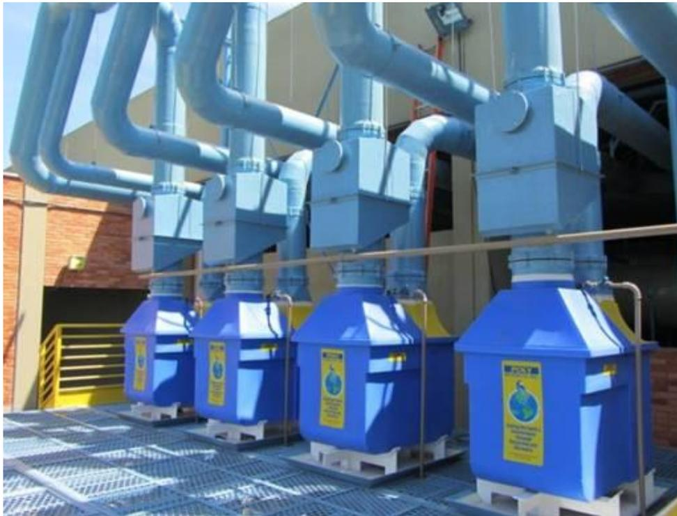
Figura 9. Exaustores usados para tratar o ar proveniente do processo de cromagem antes de lançá-lo à atmosfera
