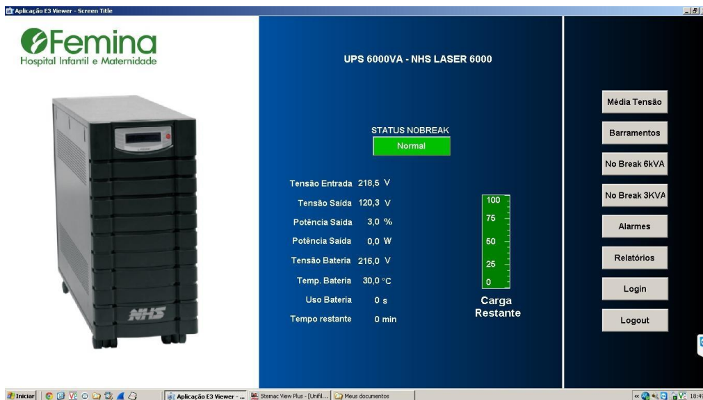
Figura 4. Tela de controle dos nobreaks
