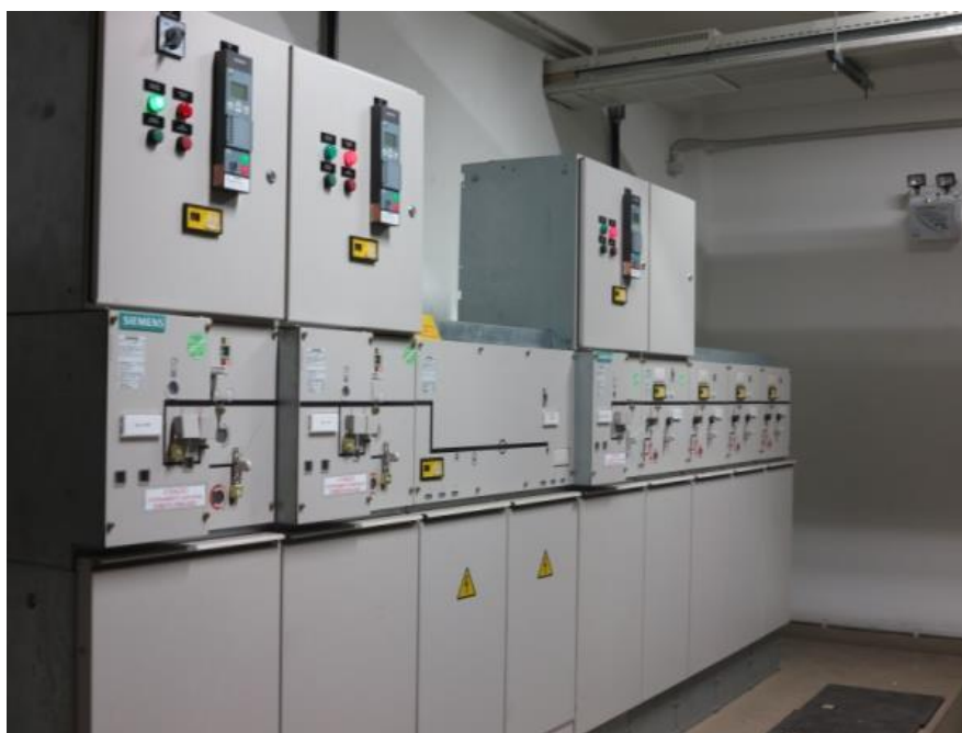
Figura 2. Cubículo de entrada da energia do hospital
