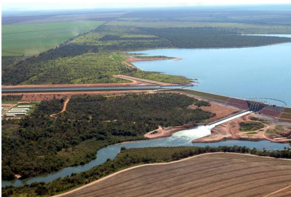
Figura 1. Imagem aérea da usina
