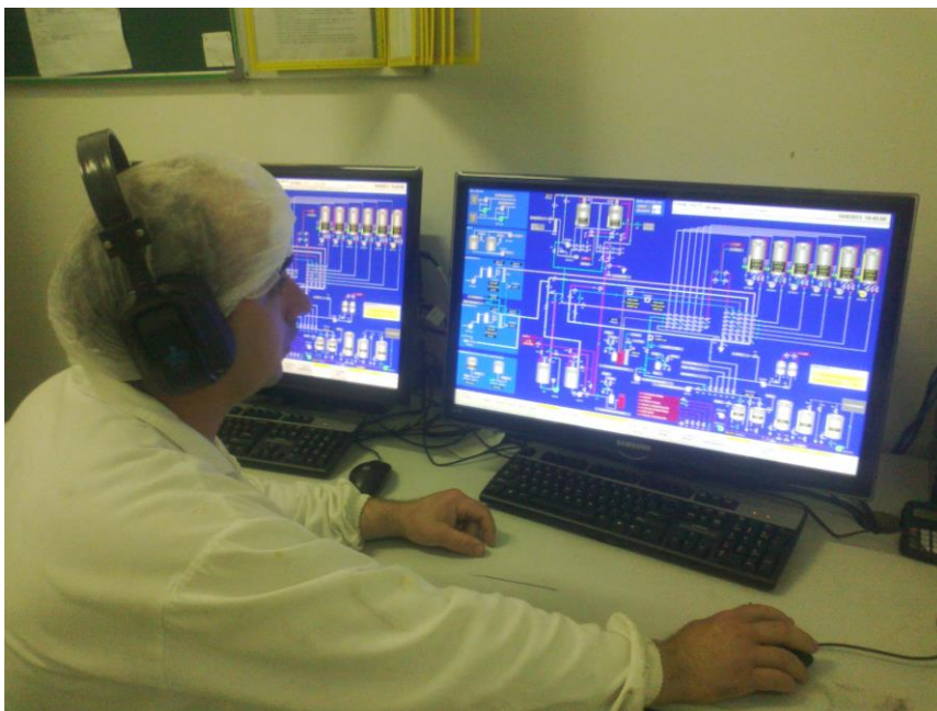
Figura 4. Operador na sala de comando
