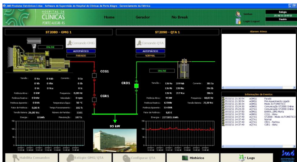
Figura 1. Tela de controle dos geradores
