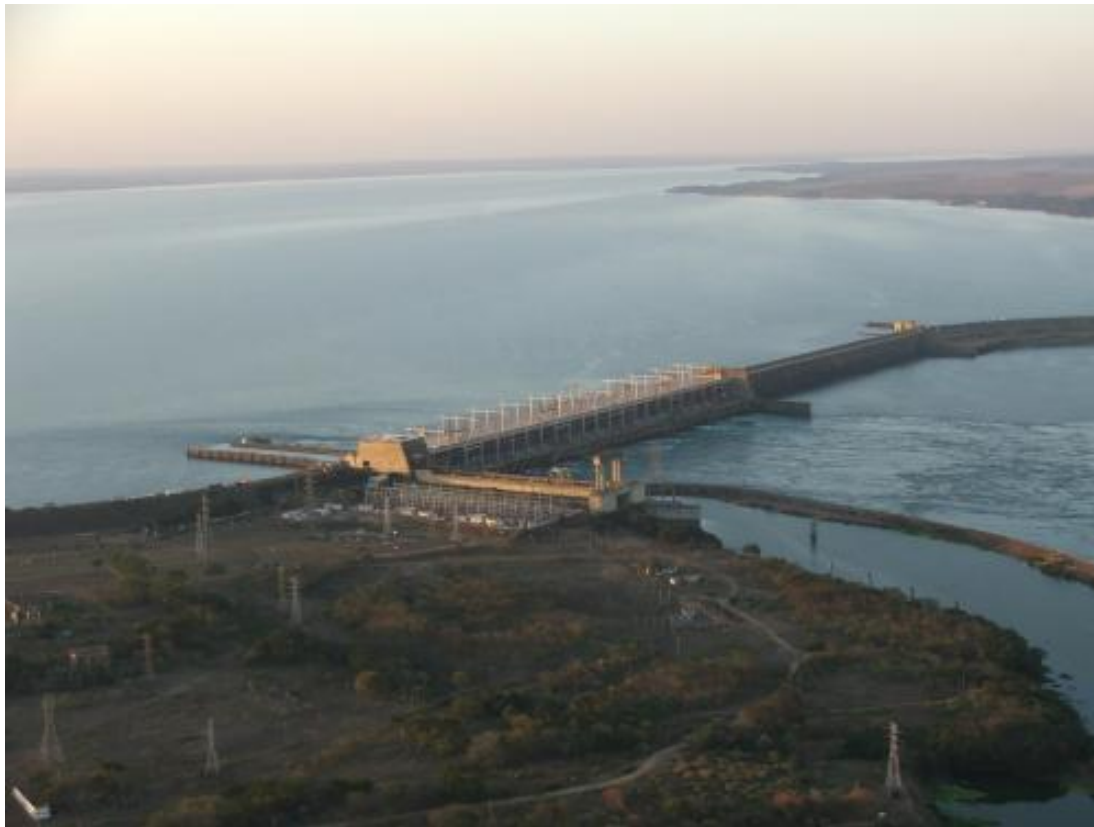
Figura 3. Usina Hidrelétrica Engenheiro Souza Dias (Jupiá)
