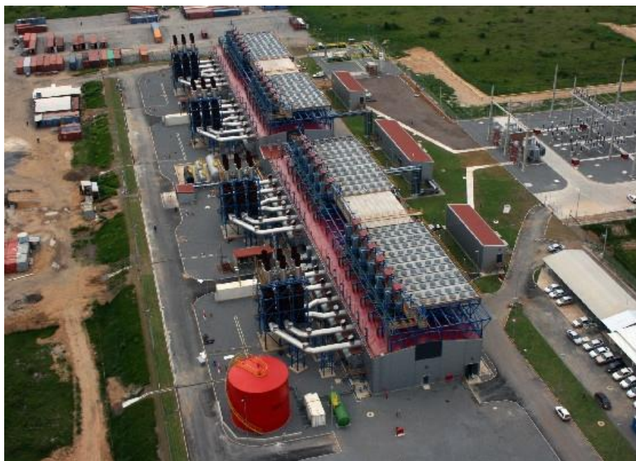
Figura 1. Subestação da Usina Termelétrica de Linhares (ES)
